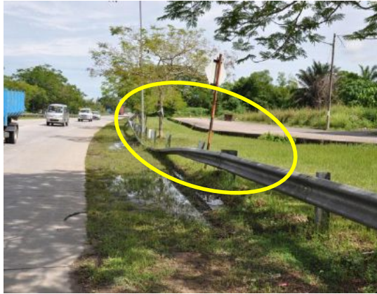
Gambar 1.15 Guardrail Tertanggal
