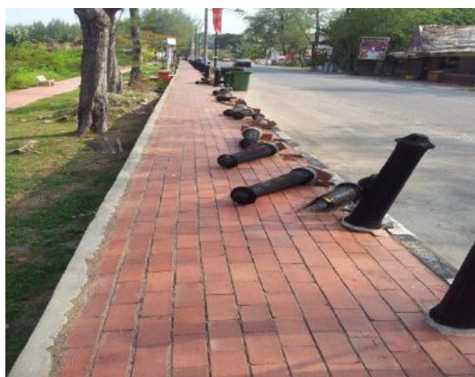
Gambar 2.41 Keadaan Bollard Yang Rosak Dan Tumbang
