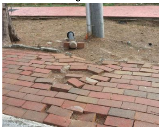
Gambar 2.41 Keadaan Bollard Yang Rosak Dan Tumbang
