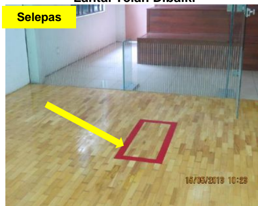
Gambar 4.4 Lantai Telah Dibaiki
