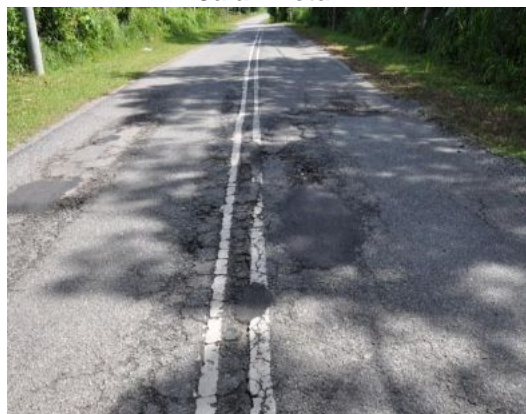
Gambar 1.4 Jalan Retak
