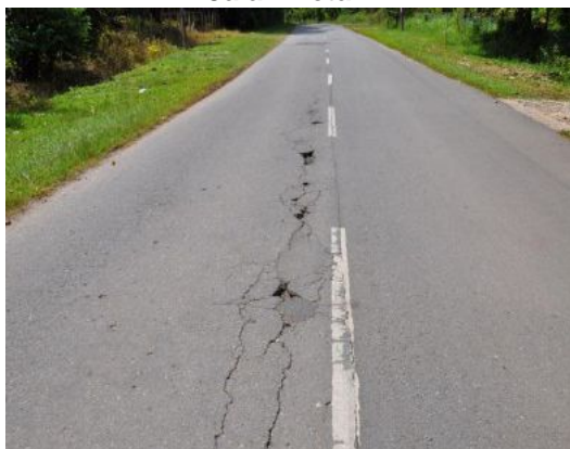
Gambar 1.3 Jalan Retak
