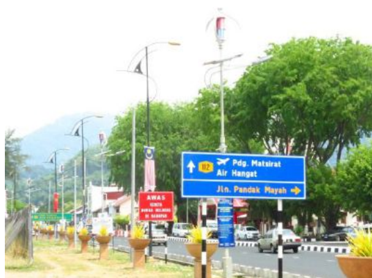
Gambar 2.42 Pemasangan Lampu L.E.D Di Antara Lampu Jalan Sedia Ada
