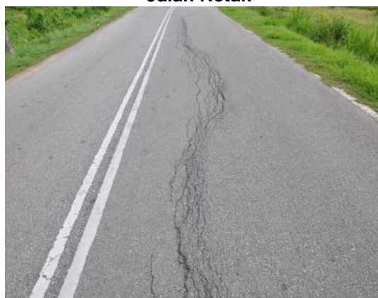
Gambar 1.5 Jalan Retak
