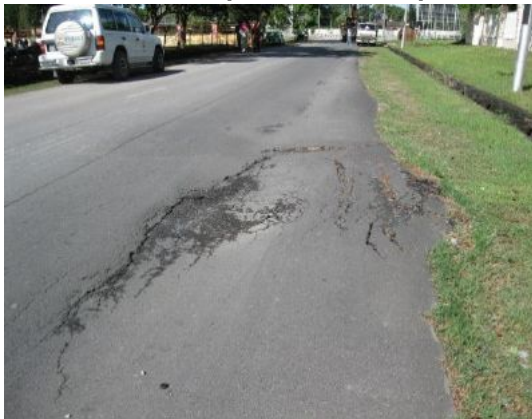
Gambar 2.11 Struktur Tepi Jalan Mendap
