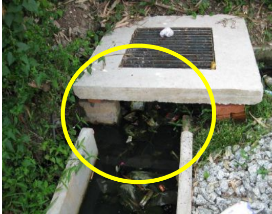
Gambar 2.15 Sambungan Parit Tidak Sempurna
