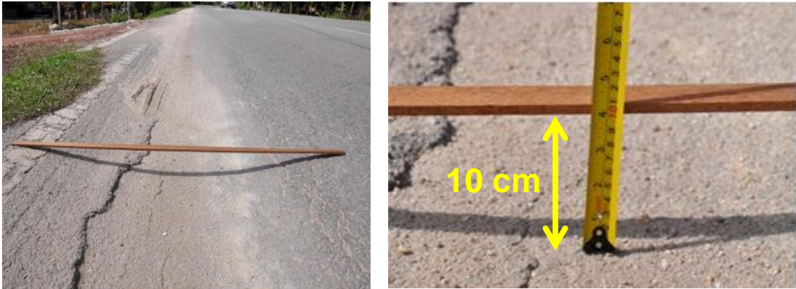
Gambar 1.7 Jalan Berlopak Dengan Kedalaman 10 cm
