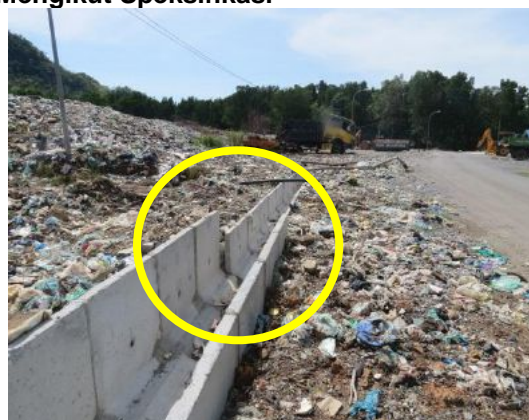
Gambar 2.1 Saiz 'U' Shape Drain Tidak Mengikut Speksifikasi
