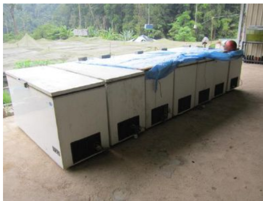
Gambar 3.14 Peti Sejuk Beku Yang Tidak Digunakan
