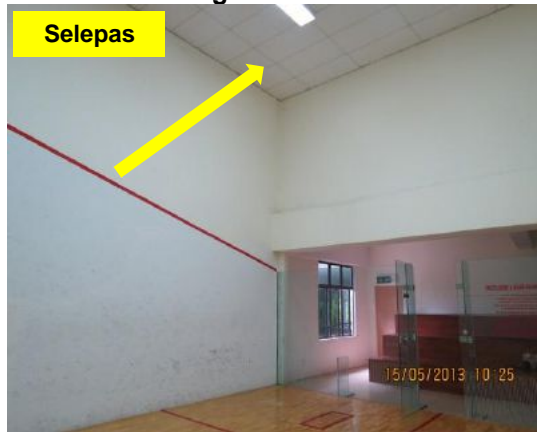
Gambar 4.8 Siling Telah Dibaiki
