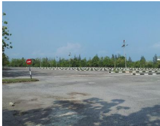
Gambar 2.43 Lampu L.E.D Yang Dipindahkan Ke Lokasi Baru Kawasan Letak Kenderaan
