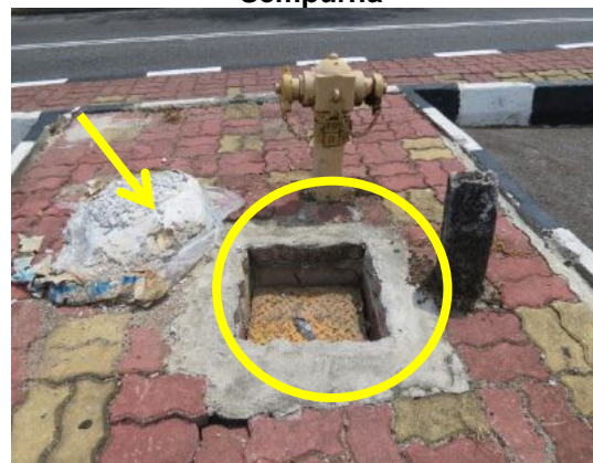
Gambar 2.20 Sisa Bahan Binaan Dan Kerja Tidak Sempurna
