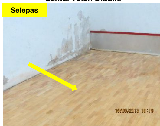
Gambar 4.2 Lantai Telah Dibaiki
