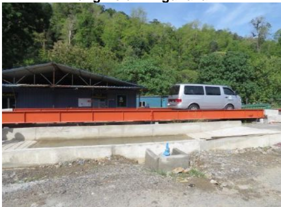
Gambar 2.36 Tempat Penimbang Kenderaan Dan Tempat Laluan Basuh Tayar Kenderaan Yang Belum Digunakan
