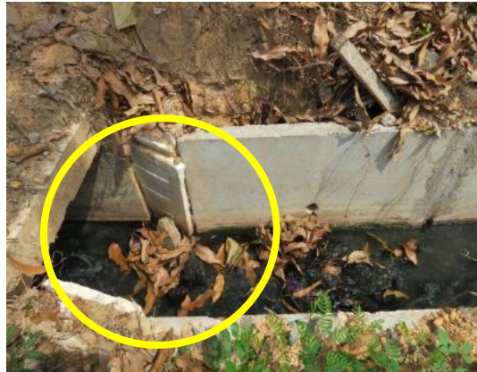
Gambar 2.22 Longkang Dibina Menggunakan Polistirin
