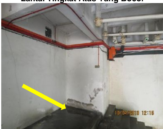
Gambar 4.17 Laluan Ke Stor Makanan Dan Stor Am Ditakungi Air Yang Menitis Dari Paip Dan Lantai Tingkat Atas Yang Bocor
