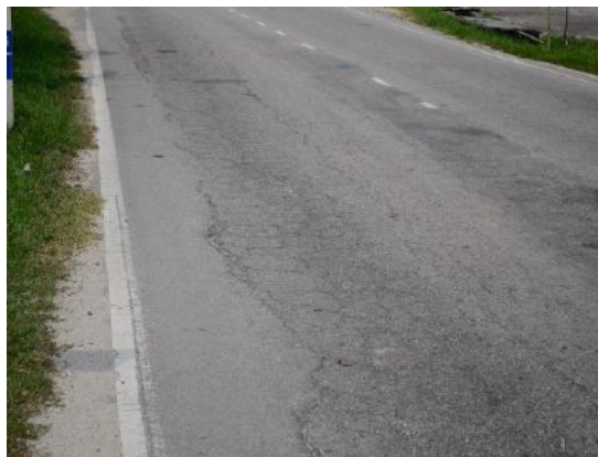
Gambar 1.8 Jalan Retak
