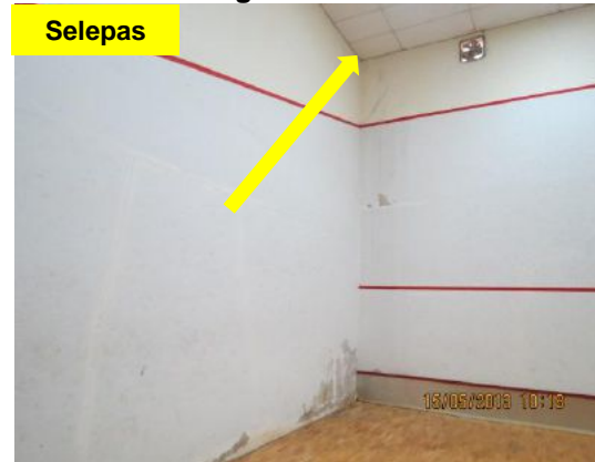
Gambar 4.6 Siling Telah Dibaiki
