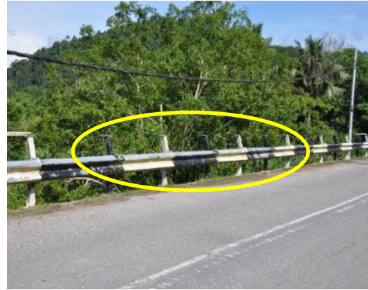
Gambar 1.16 Handrail Jambatan Tertanggal
